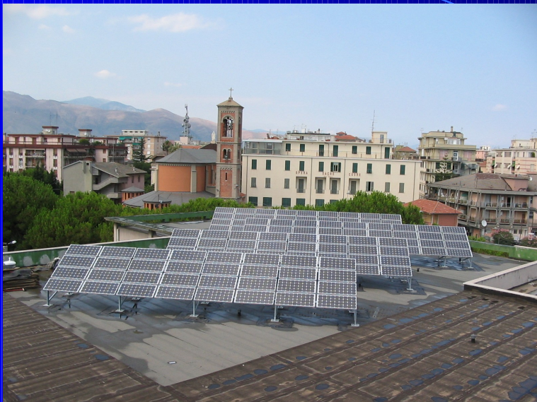
Scuola Elementare di via degli Orti - Comune di Albenga Impianto fotovoltaico da 10,2 kWp connesso alla rete BT
